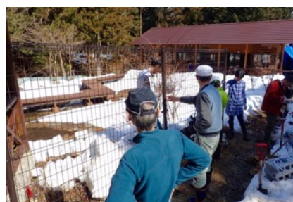
高さ2mのガーデンフェンスを施工 3/4
