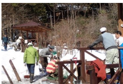
老朽化した木柵の解体撤去 3/4
