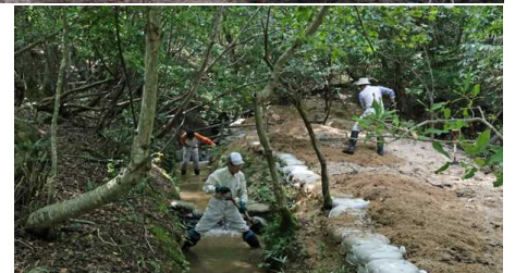
北部湿原奥浚渫作業越流部分の築堤(15/09/19)
