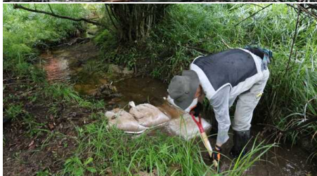
湿原内水路の下浸防止堰堤設置(15/08/26)
