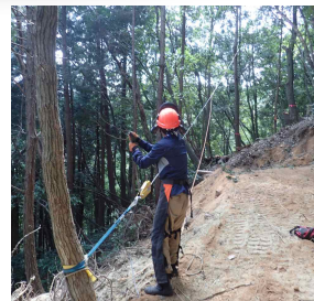
狭い空間での伐倒作業
