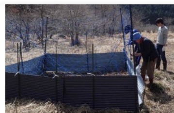
一般参加者とネット再設置作業
