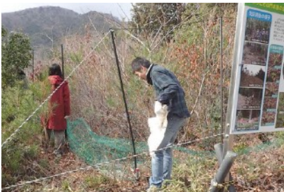
午後から老朽化したネットの撤収作業
