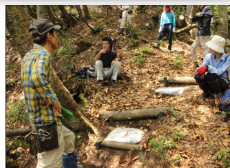
会員と階段修繕作業、昨年の台風被害木の処理 Photo 藤本H
