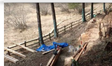
製材して木道設置 3/1
