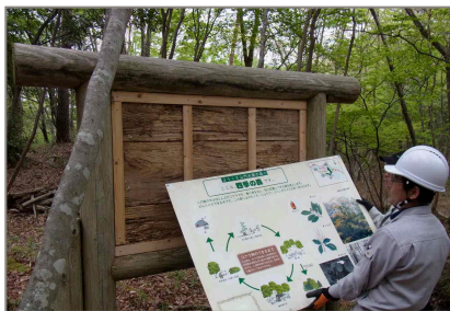
腐食した裏板を補強 2013.5.10
