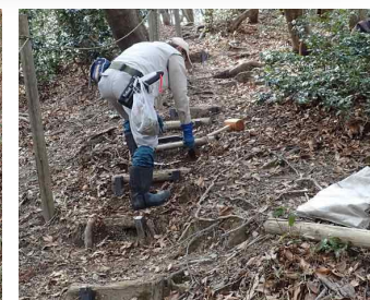
破損した階段を修繕 3月27日
