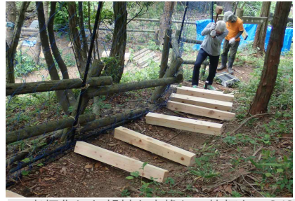
老朽化した部材を交換して杭打ち 6/6
