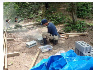
ブロックのカット作業 6/6
