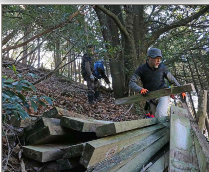
解体した古材を撤去 3月7日
