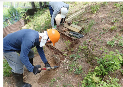
腐食した階段横木を交換 5/15
