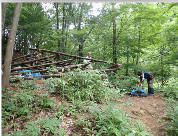
破損した炭焼き小屋の解体 7/3
