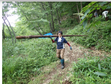
解体した部材の撤去 7/3
